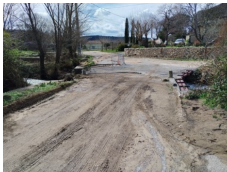
Pont Ancienne Eglise après passage tempête Monica
