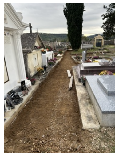
Travaux en cours
