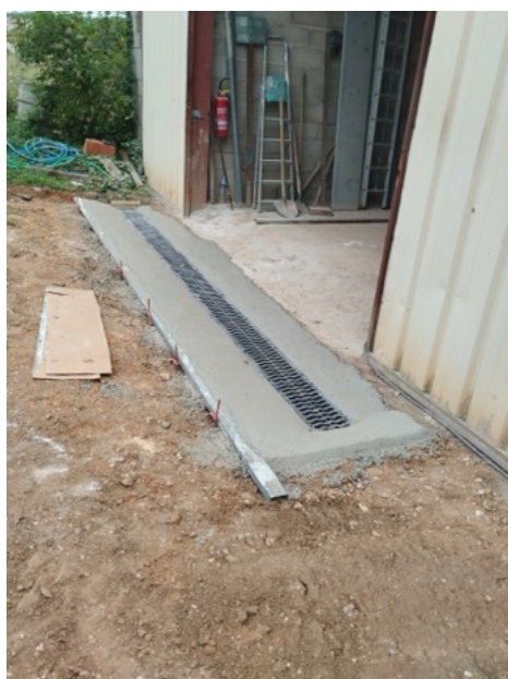
Mise hors d'eau du hangar communal
