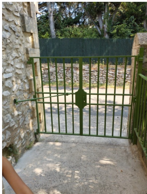
Réfection des ferronneries du Théâtre de Verdure
